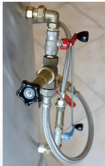
■ Tuyaux et robinets de remplissage
