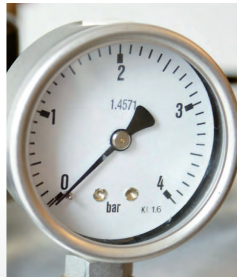
■ Gestion de la pression dans la cuve
